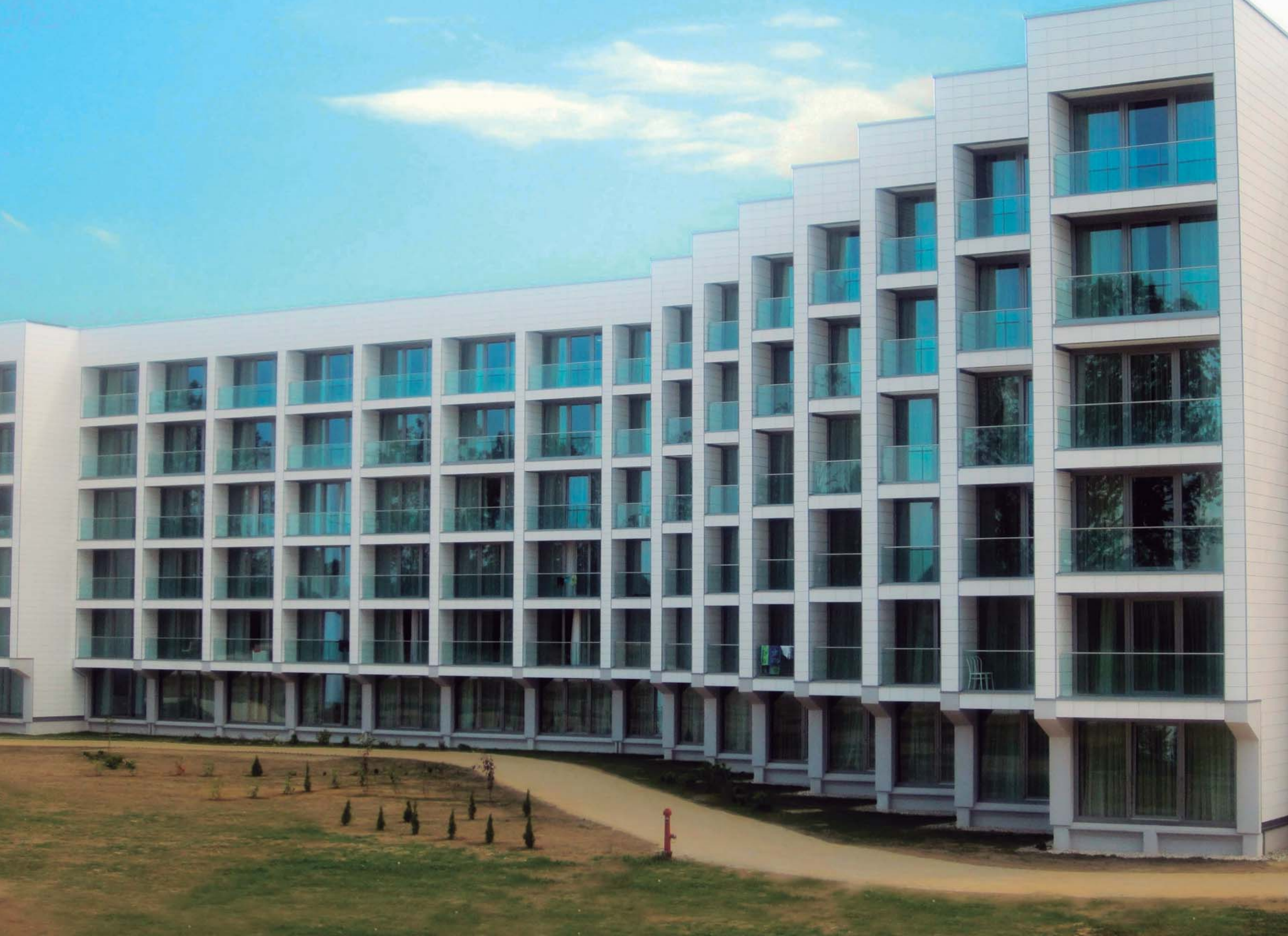
Proyecto / Project : Resort Spa Terme Čatež. Čatež (Slovenia)
